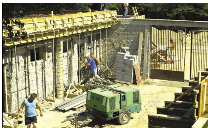
Folynak az építési munkálatok a Pomléban
