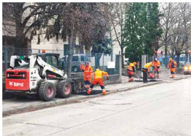
Oprava chodníka na Školskej ulici
