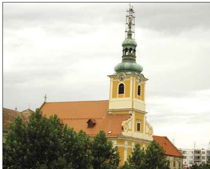
... és felújítás után
