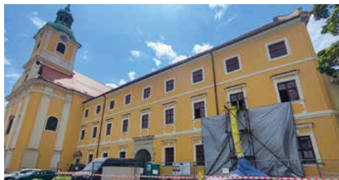
Spojenie historickej budovy a novodobej zábavy urobí z Korony moderný kláštor (Fotoarchív)
